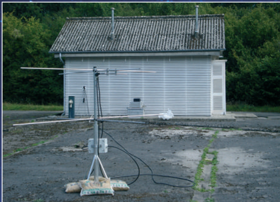
Fig.2. Antenne émettrice située sur le site du centre de Physique du Globe à Dourbes. Le générateur de signal et l'amplificateur de puissance se trouvent à l'intérieur de la cabane en arrière-plan.
